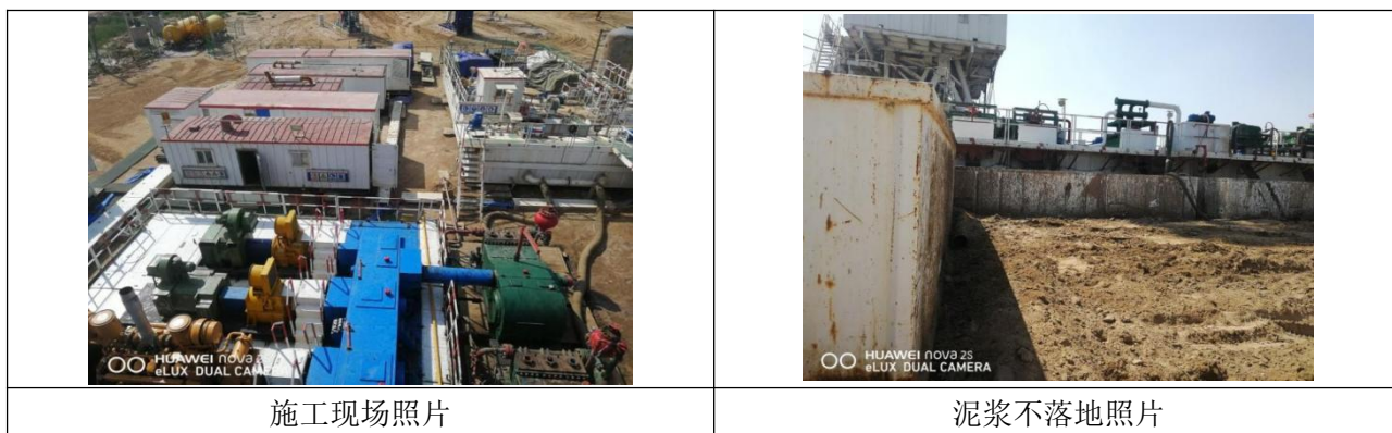
图 1 施工现场照片图
