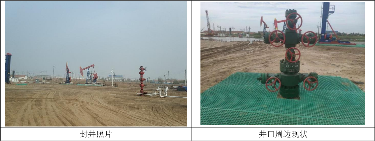
图 6 井场现状恢复照片
