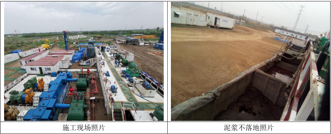
图 1 施工现场照片图
