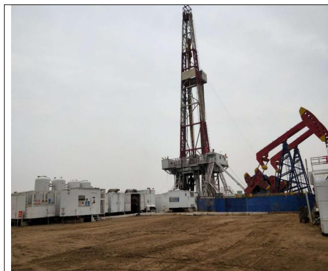
施工现场照片
