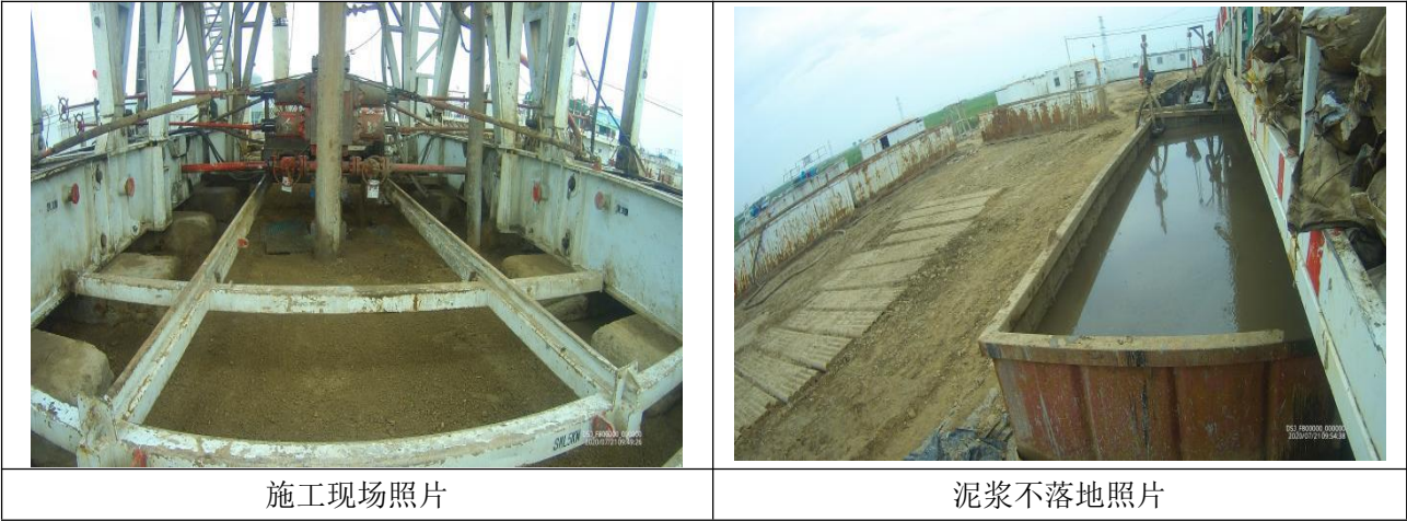
图 1 施工现场照片图
