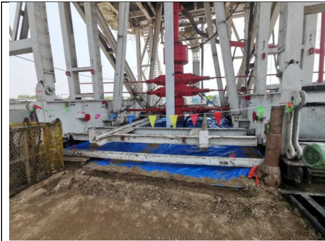
施工现场照片
