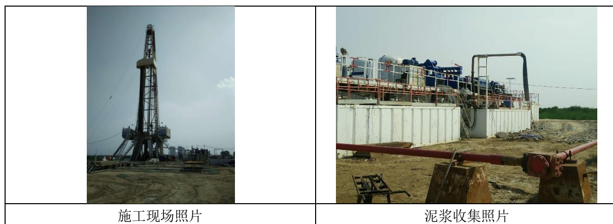
图 1 施工现场照片图
