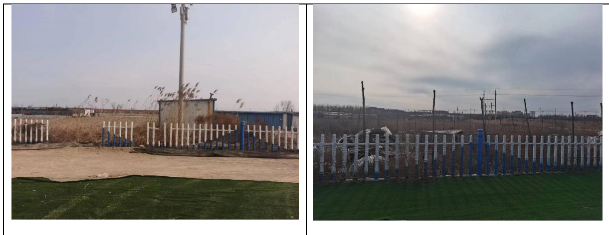
图 5 井场周边生态恢复照片
