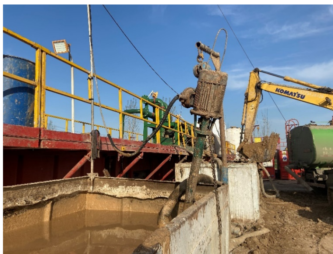
图 4-3 泥浆不落地现场处理图
