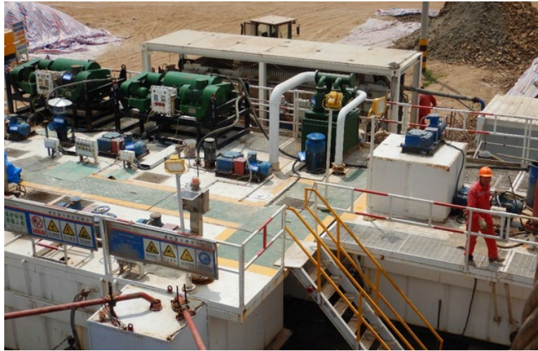
图 4-2 泥浆不落地现场处理图
