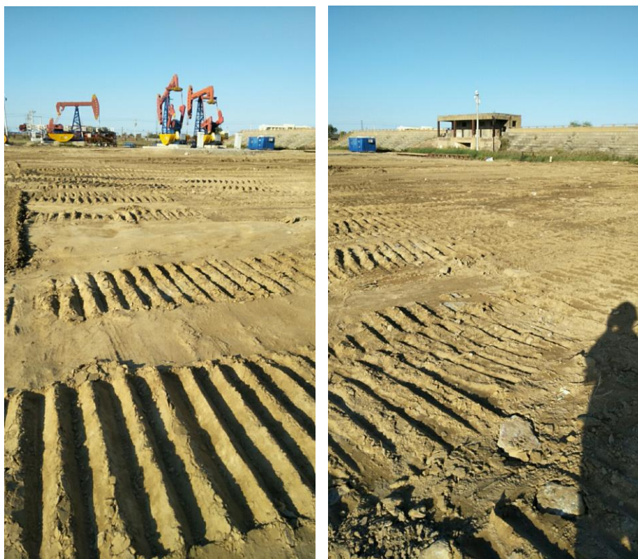
图 4-3 施工结束现场平整照片
