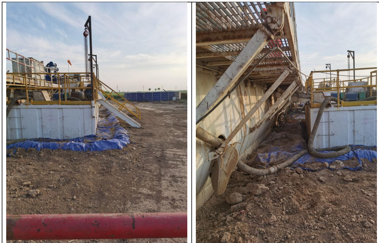
图 4-2 孤古 2-斜 1 井钻井现场泥浆不落地装置照片
