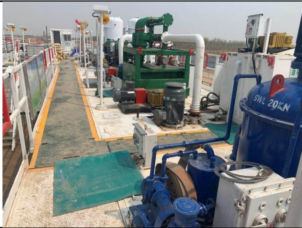
施工现场照片
