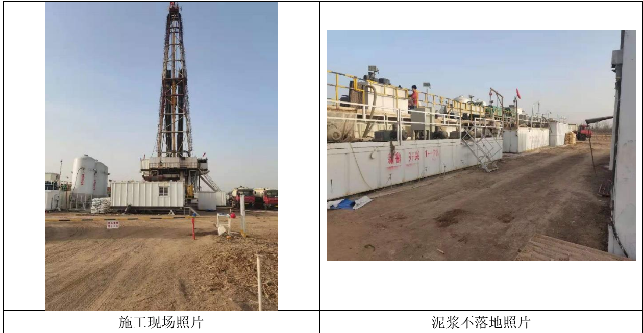
图 1 施工现场照片图
