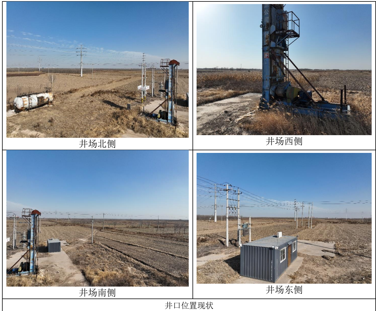
图 4 井场现状恢复照片
