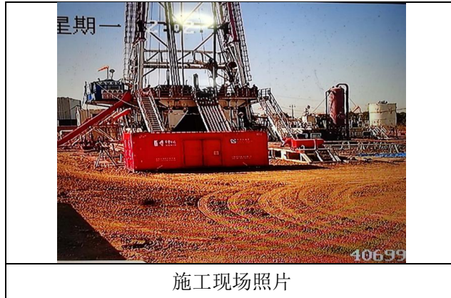
图 1 施工现场照片图
