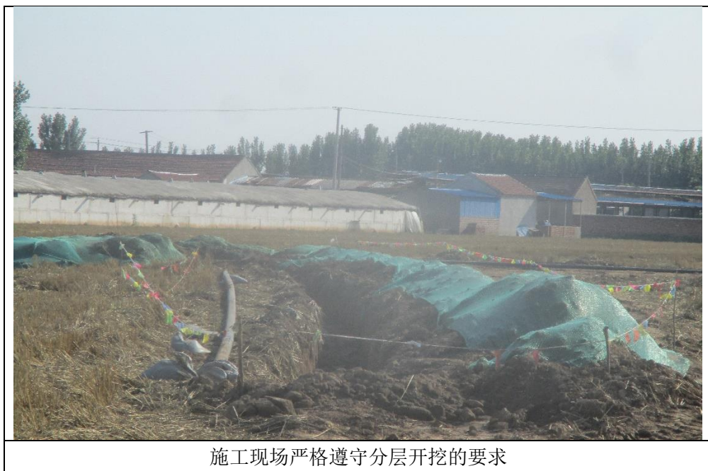
图 5-2 管线施工期生态保护措施落实情况照片
