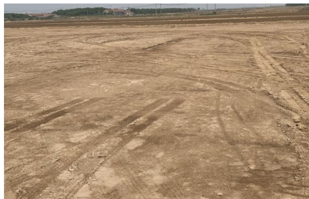
井场平整照片
