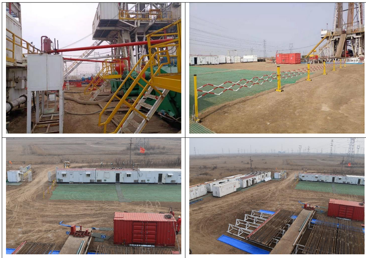
图 9 钻井现场施工设施防渗措施照片
