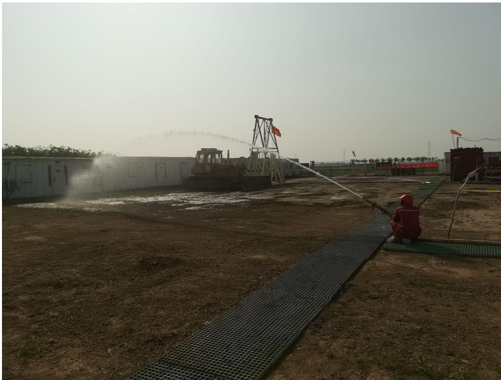
图 12 施工现场洒水降尘措施照片
