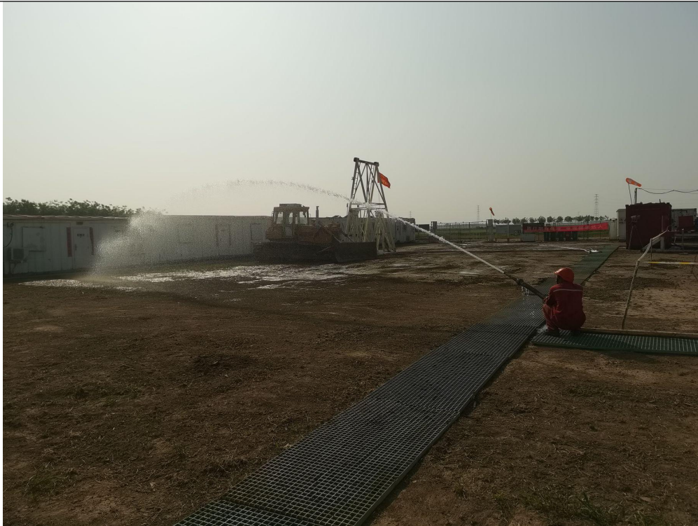
图 6 施工时现场洒水降尘照片
