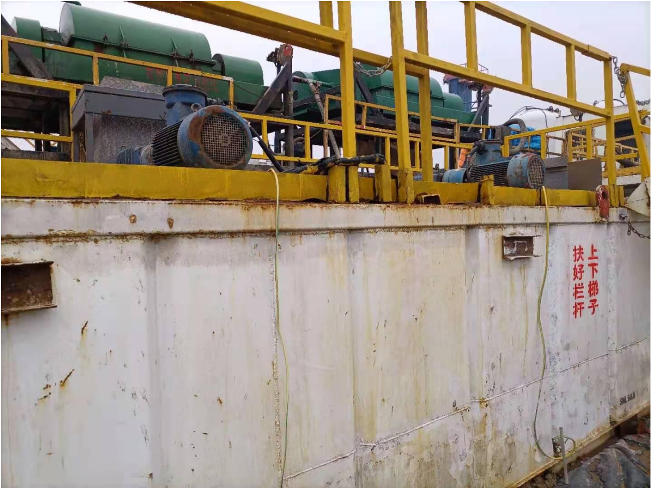
图 13 义古 107 井钻井现场泥浆不落地装置照片
