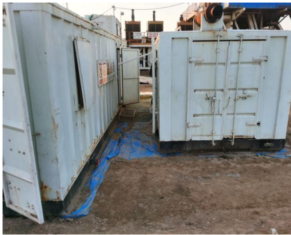
钻井现场施工设施防渗措施照片
