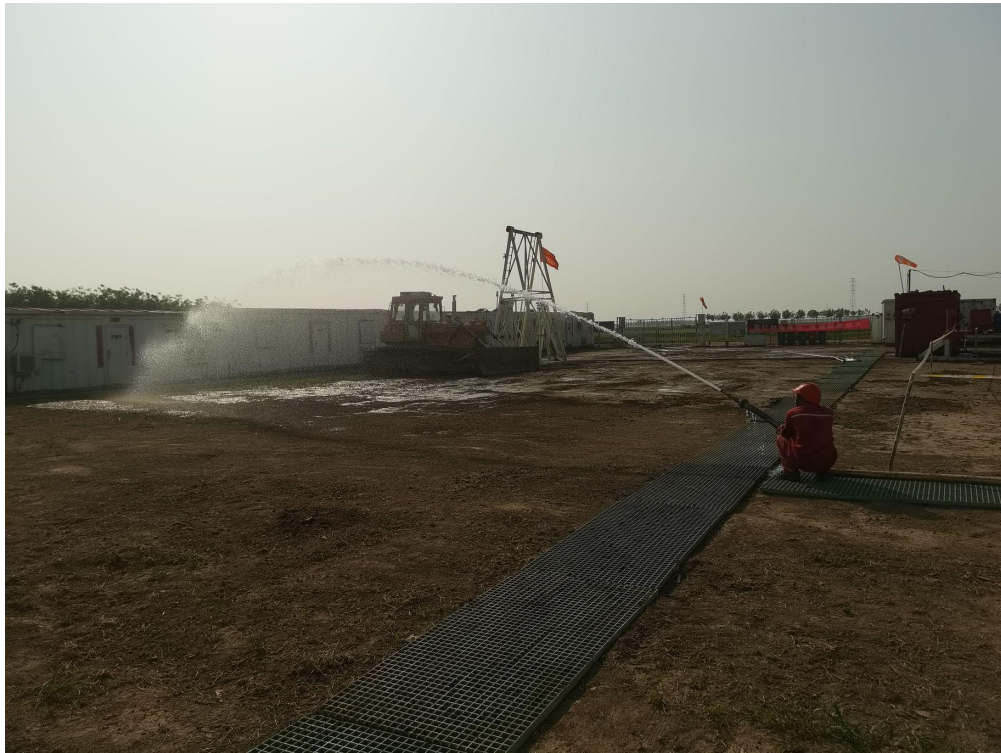
图 6 施工时现场洒水降尘照片
