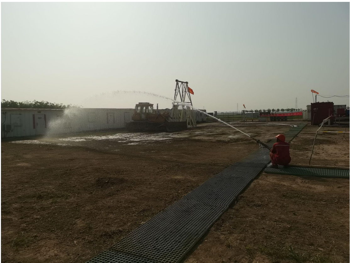
图 12 施工现场洒水降尘措施照片
