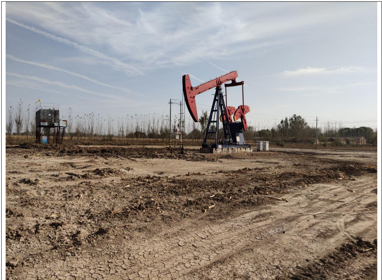
图 8 施工结束现场平整照片
