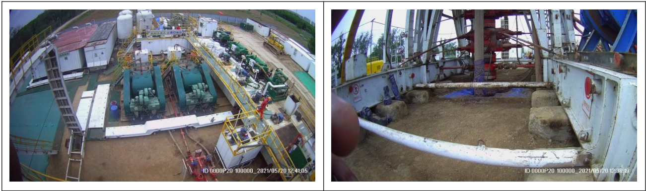
图 6 钻井现场施工设施防渗措施照片
