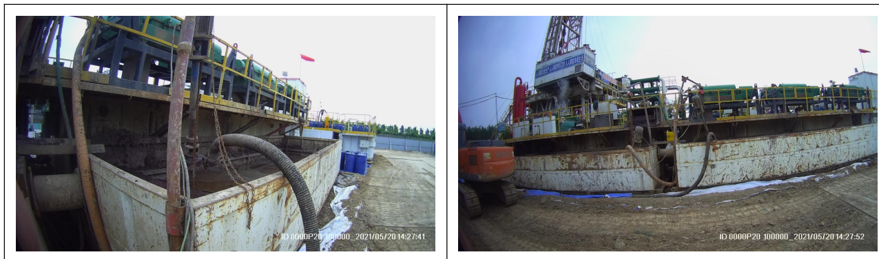
图 9 王斜 651 井钻井现场泥浆不落地装置照片
