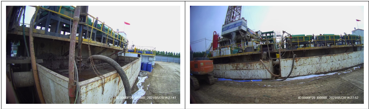
图5 王斜 651 井钻井现场泥浆不落地装置照片
