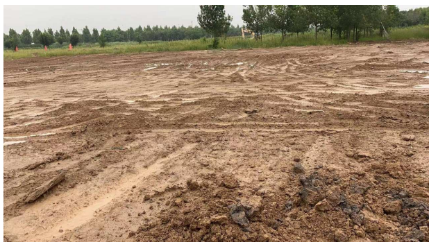
井场平整照片
