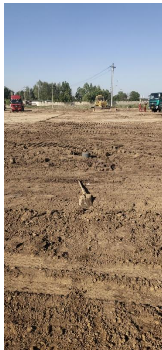
井场平整照片
