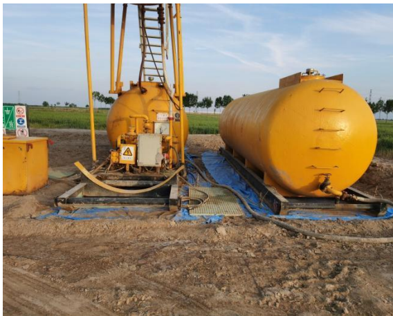
钻井现场施工设施防渗措施照片
