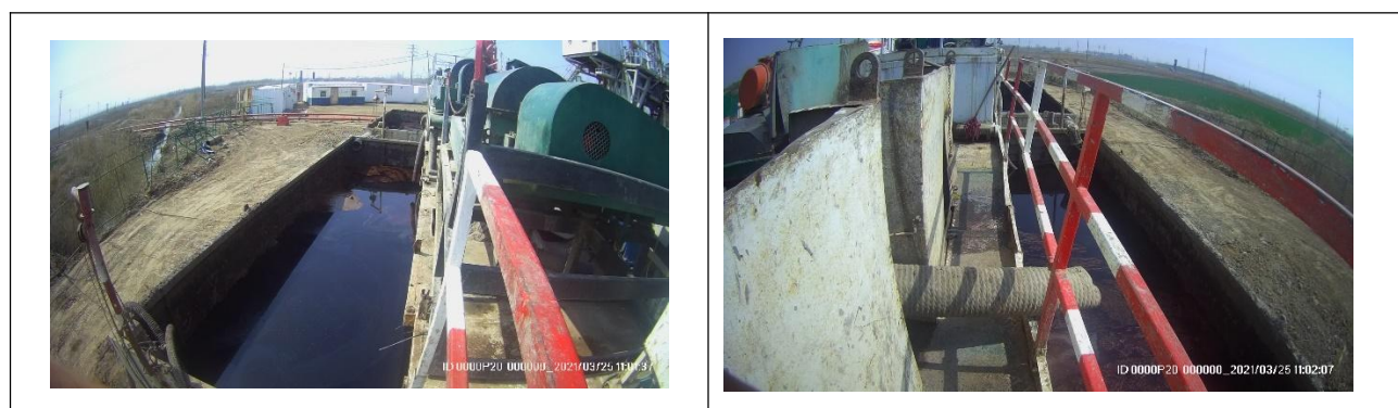
图 13 王斜 551 评价井钻井现场泥浆不落地装置照片
