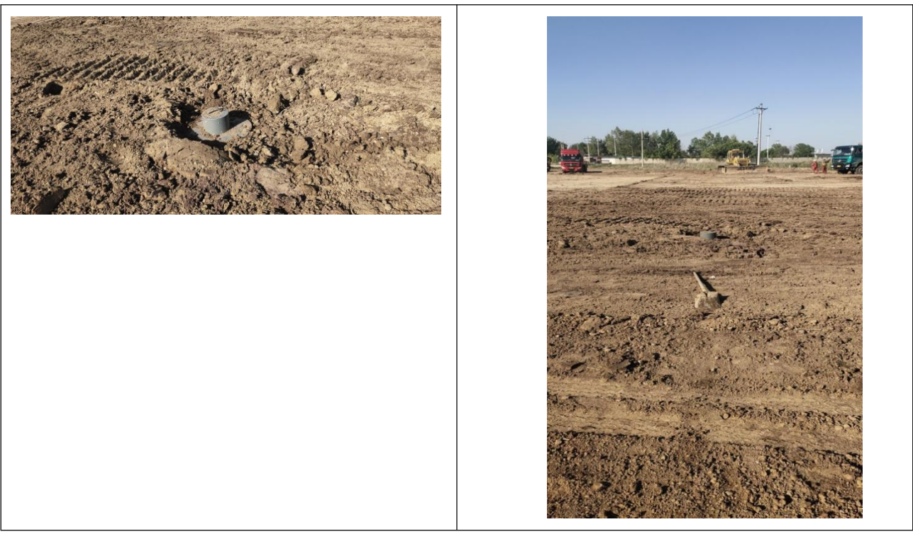
图 14 施工结束现场平整照片
