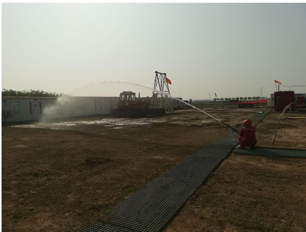
图6 施工时现场洒水降尘照片
