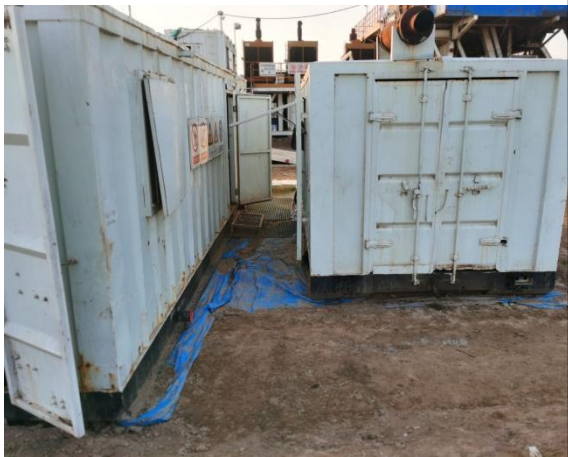
钻井现场施工设施防渗措施照片
