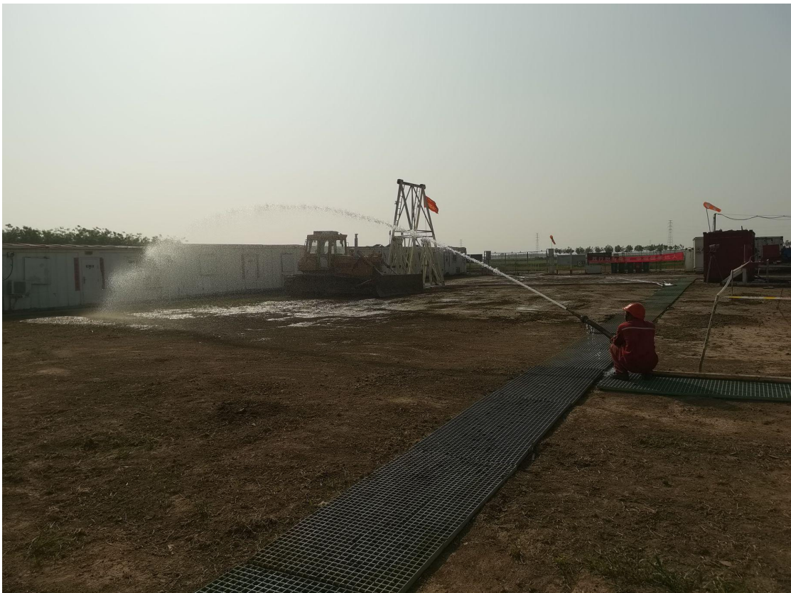
图 12 施工现场洒水降尘措施照片
