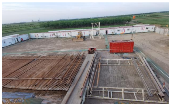
钻井现场施工设施防渗措施照片
