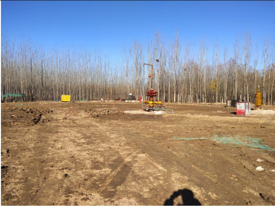
图 9 施工结束现场平整照片
