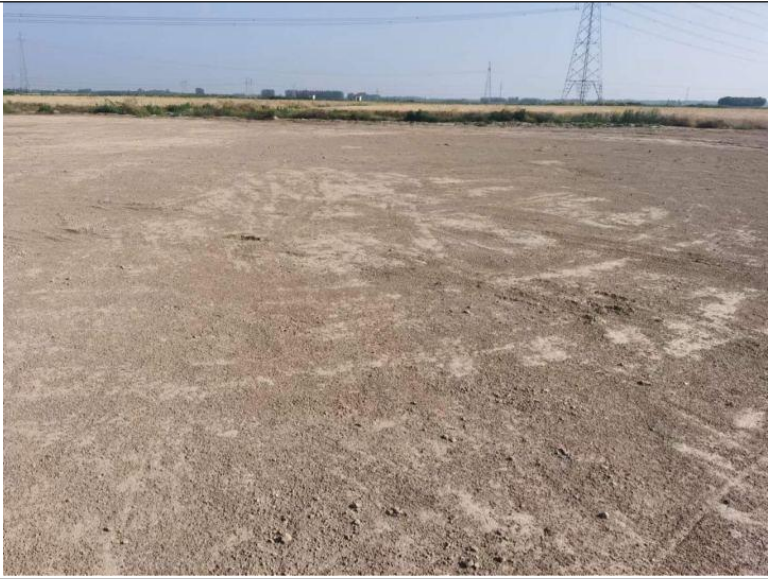
图 8 施工结束现场平整照片
