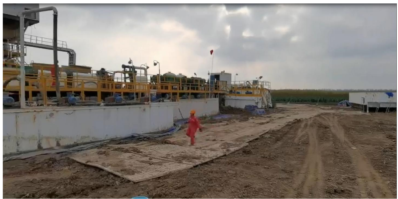
图 6 钻井现场施工设施防渗措施照片
