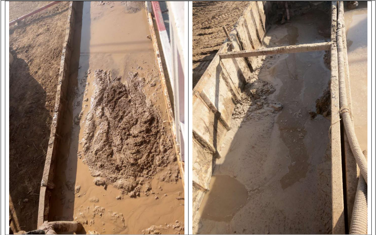
图 7 “泥浆不落地”照片
