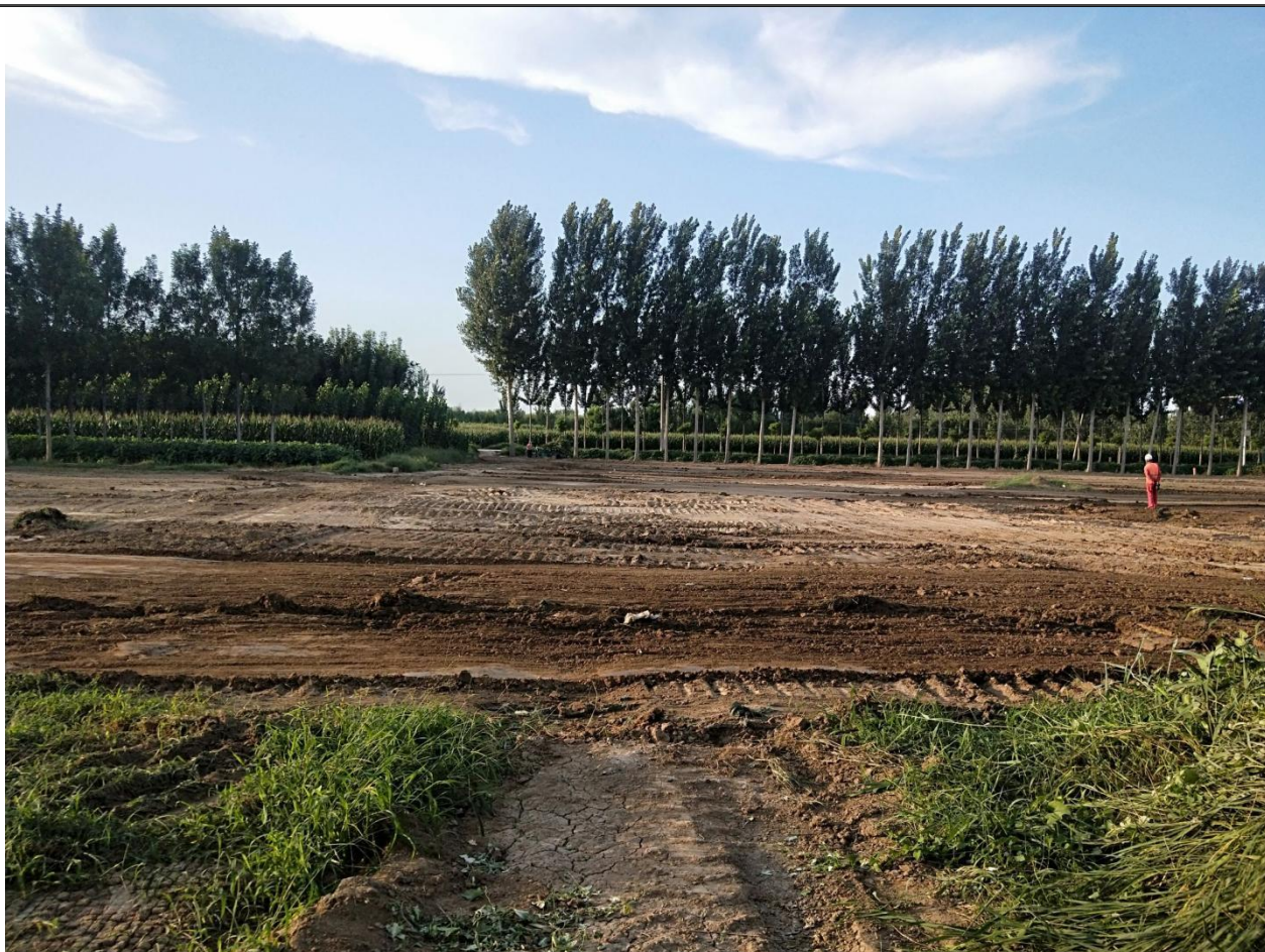
图 11 施工结束现场平整照片
