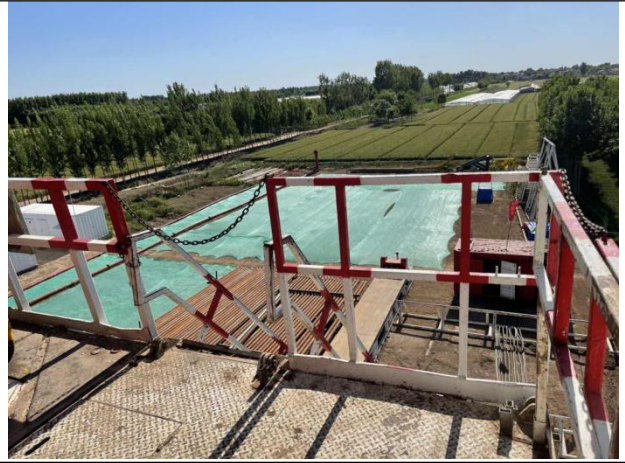
图 8 钻井现场施工设施防渗照片
