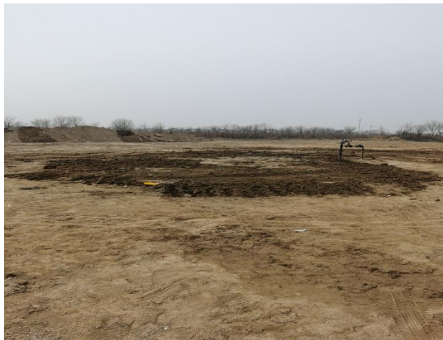
图 14 完井平整照片
