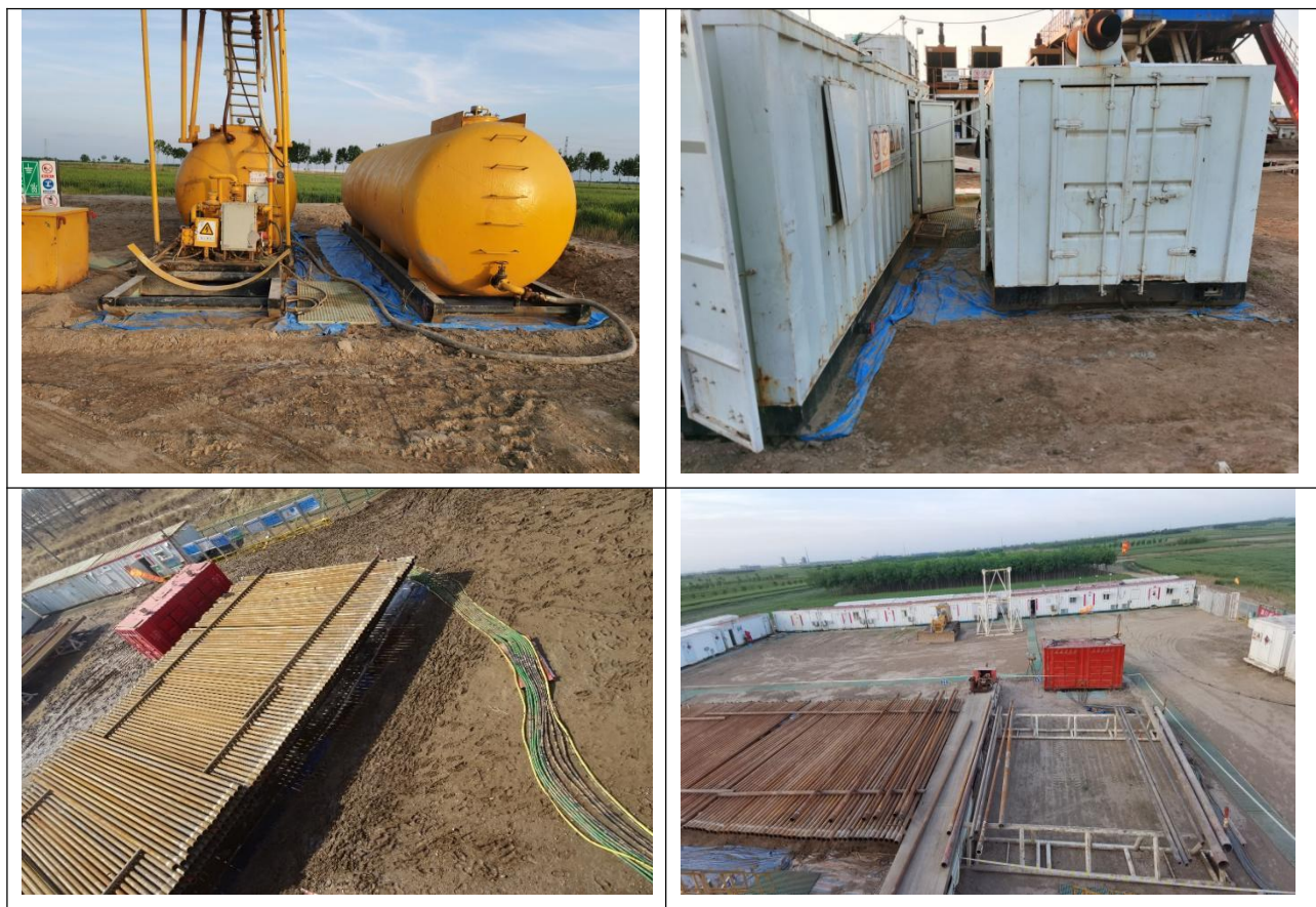
图 9 钻井现场施工设施防渗措施照片
