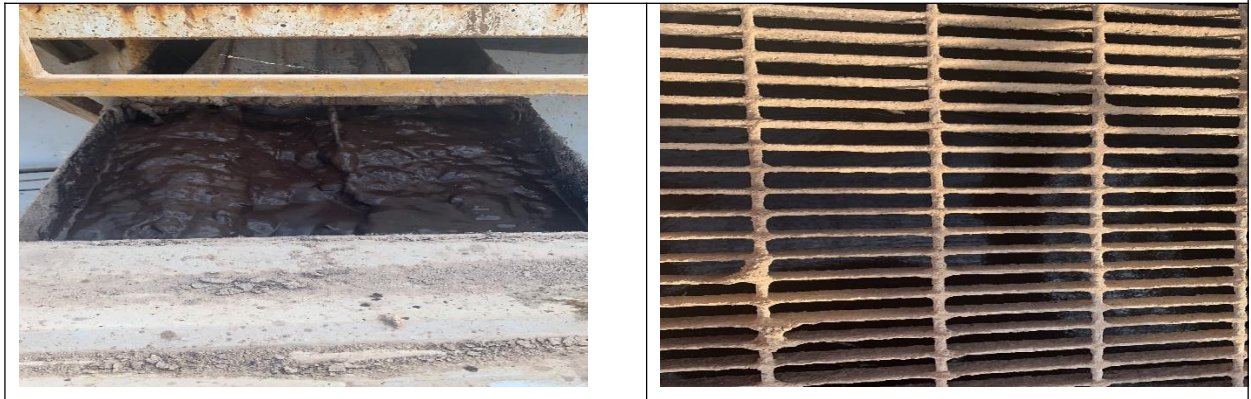
图 13 孤南斜 311 钻井现场泥浆不落地装置照片
