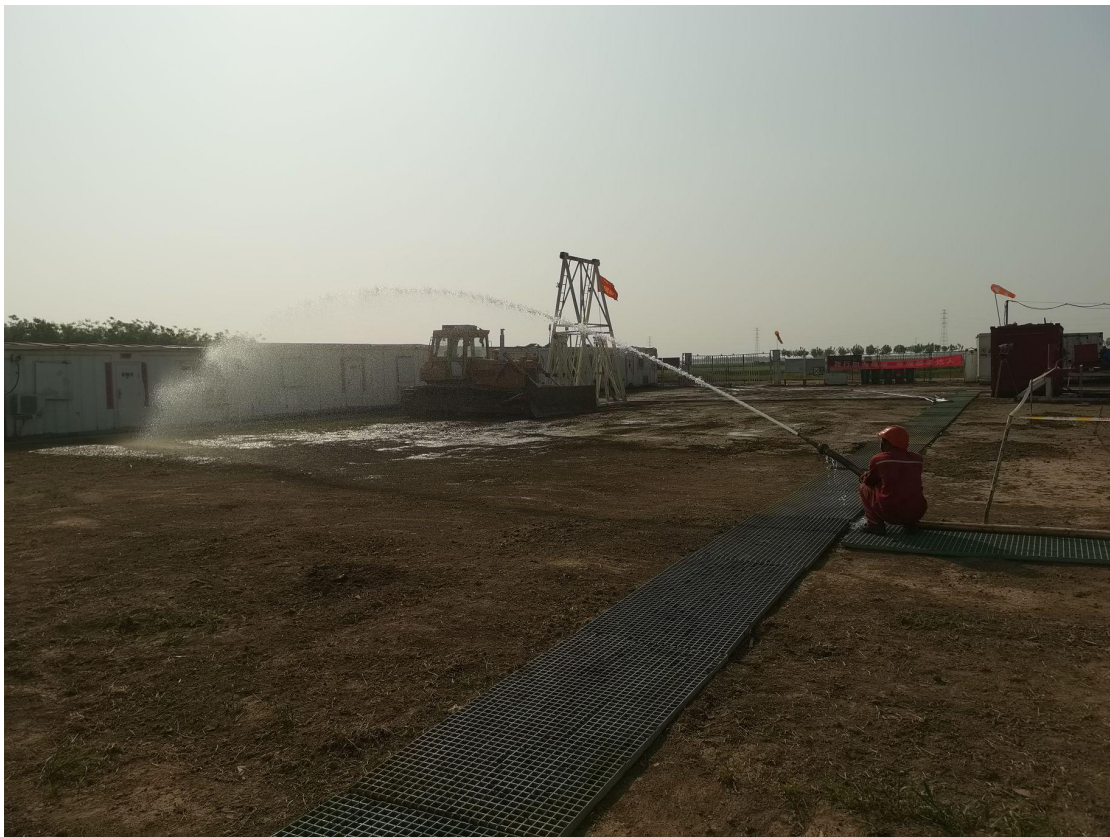
图 12 施工现场洒水降尘措施照片
