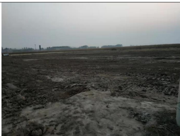
图 11 施工结束现场平整照片
