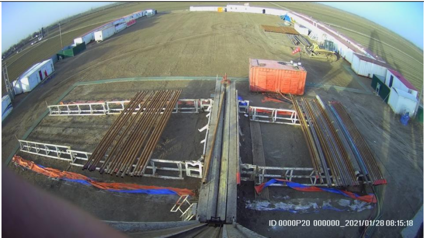
图 8 钻井现场施工设施防渗照片
