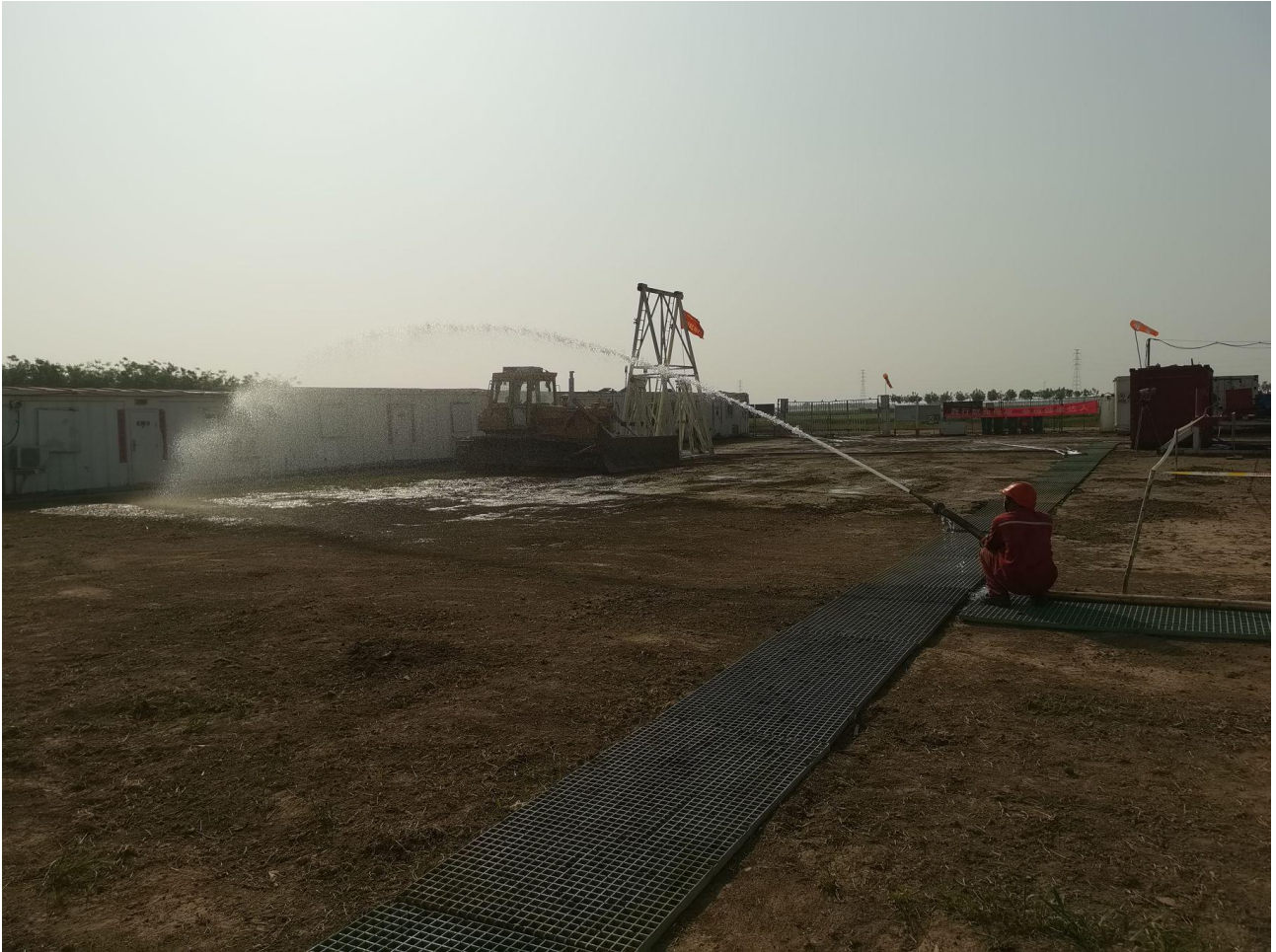
图 4 施工时现场洒水降尘照片
