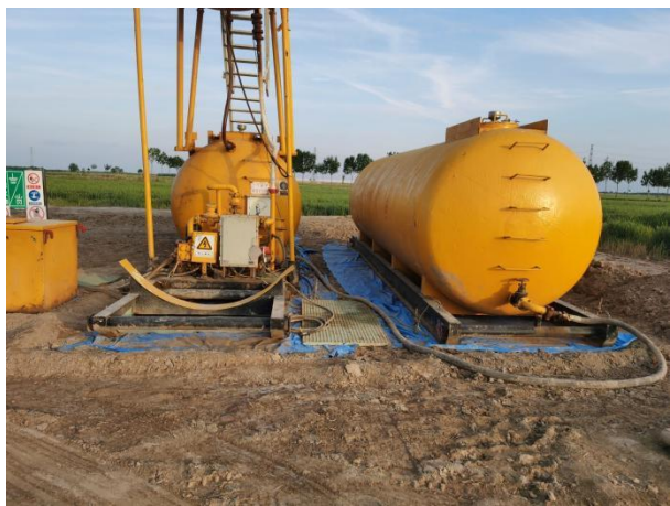
钻井现场施工设施防渗措施照片
