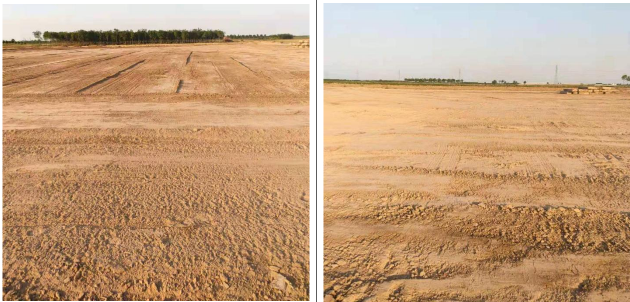
图 13 施工结束现场平整照片
