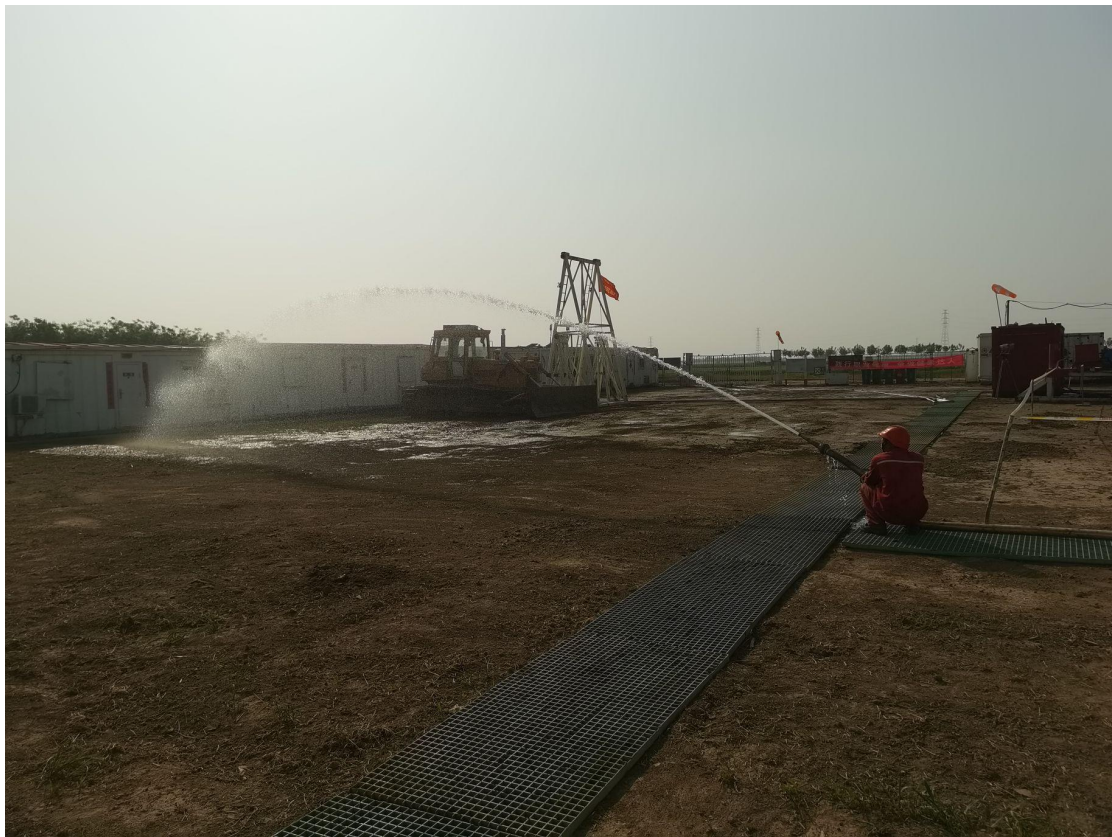
图 11 施工现场洒水降尘措施照片
