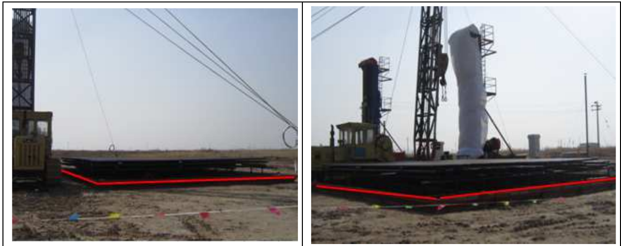
图 5-1 井下作业船型围堰（非本工程项目）
