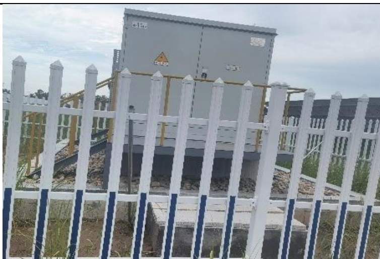
升压变压器配套事故贮油池
