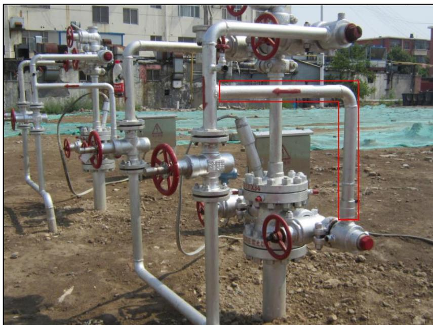
图 5.2-5 油套连通装置照片
