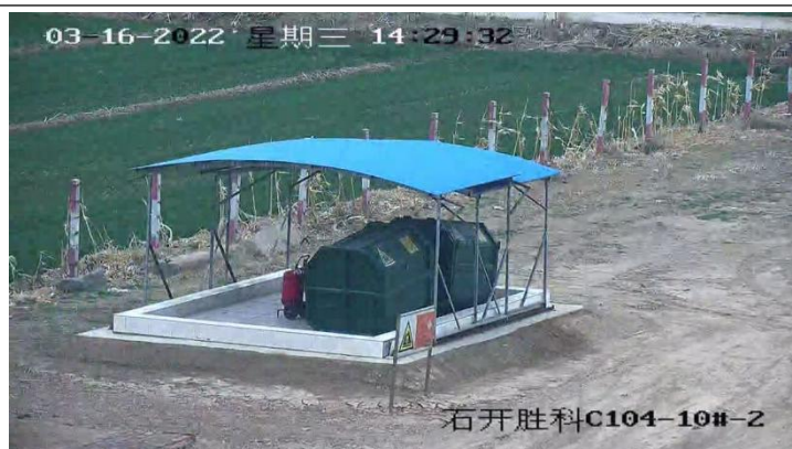
图 5-27 草 104-10 井场油泥砂暂存点
