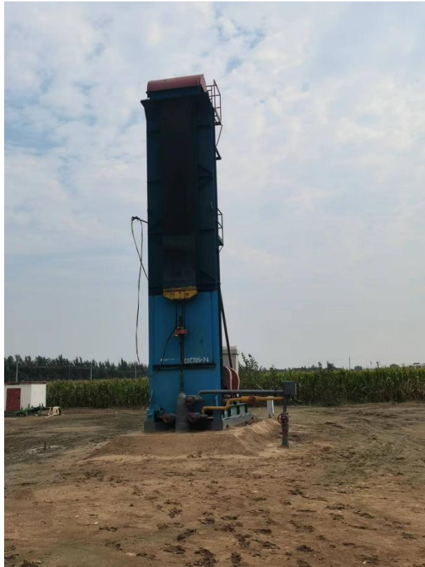
图 5-1 井场施工现场场地恢复情况
