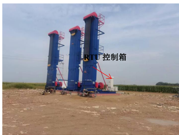
图 4-1 井场 RTU 控制箱
