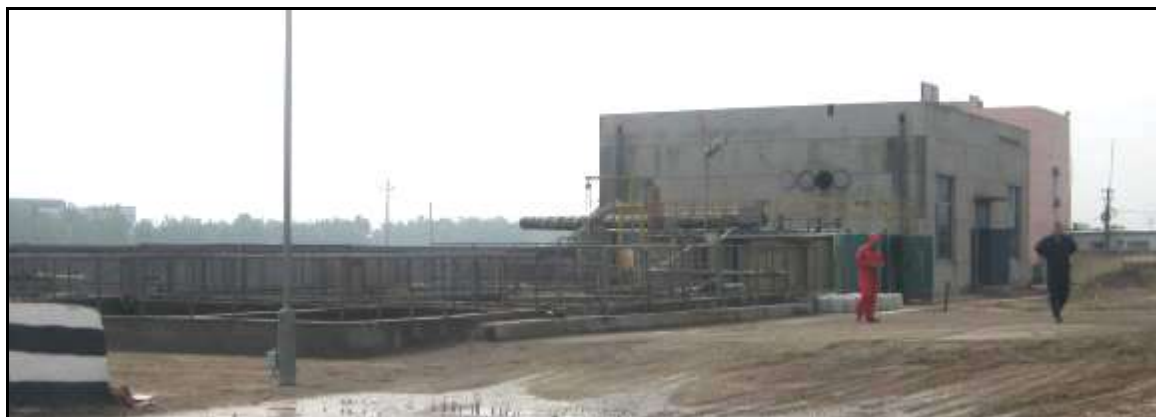
图 3-4 纯梁首站废液处理站现场图片
