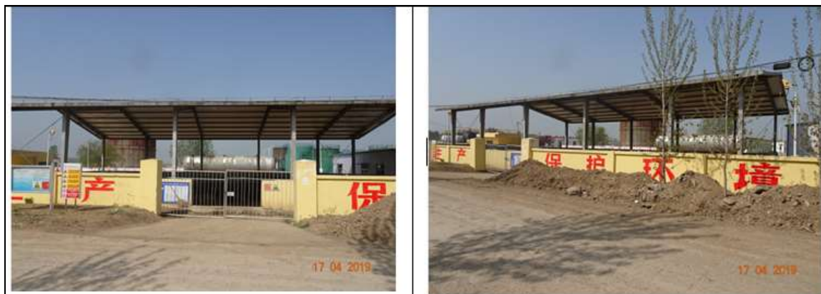
图 3-7 樊家输油站油泥砂贮存池现场照片
