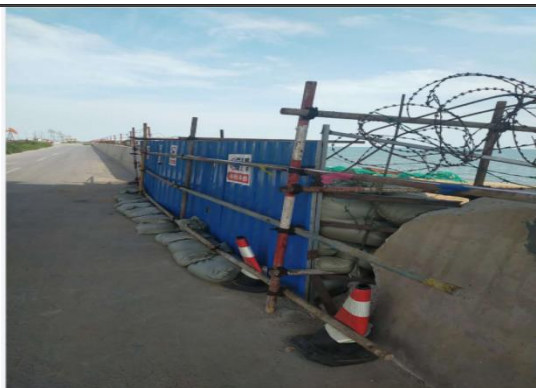
临时施工围栏
