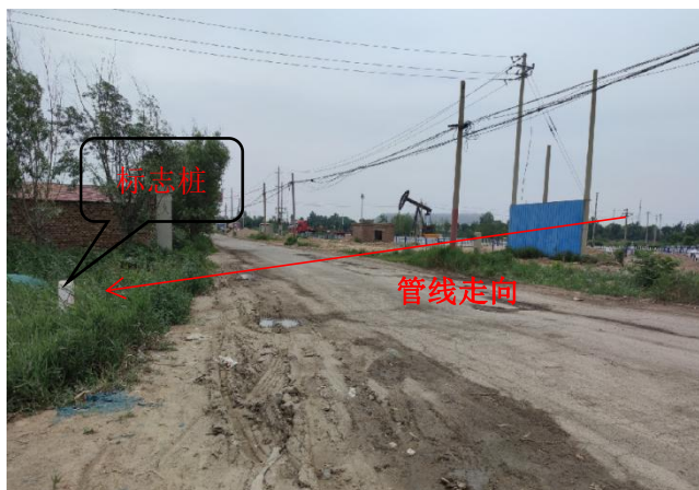
图 5-3 东十二里村南侧道路（顶管穿越）
