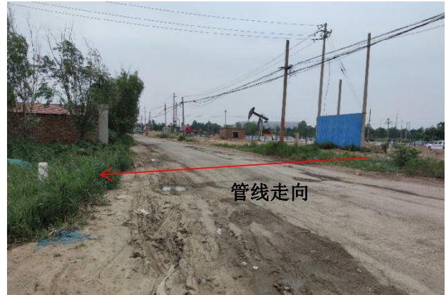
图 6-2 顶管穿越东十二里村南侧道路
