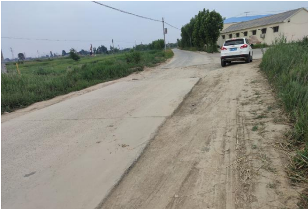
图 6-1 顶管穿越西十二里村西侧水泥路
