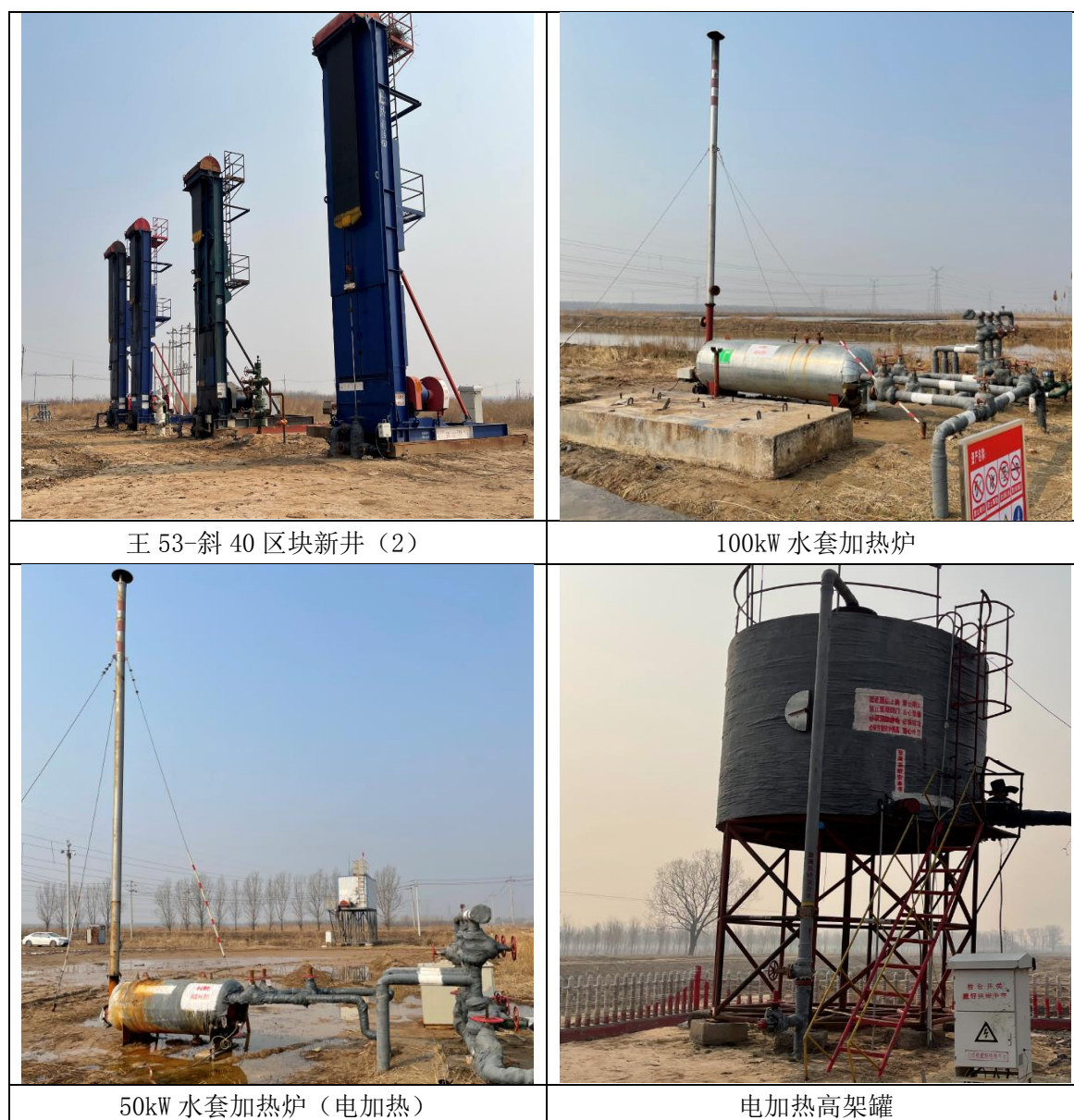
图 3-8 现场建设情况
