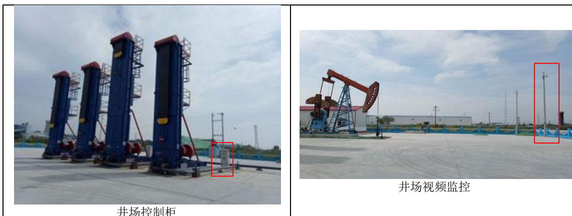
图 3 辅助工程现场照片
