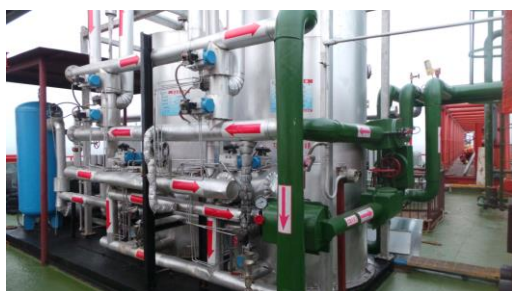
图7.3-3 金刚砂过滤器及注水泵存放现场照片
