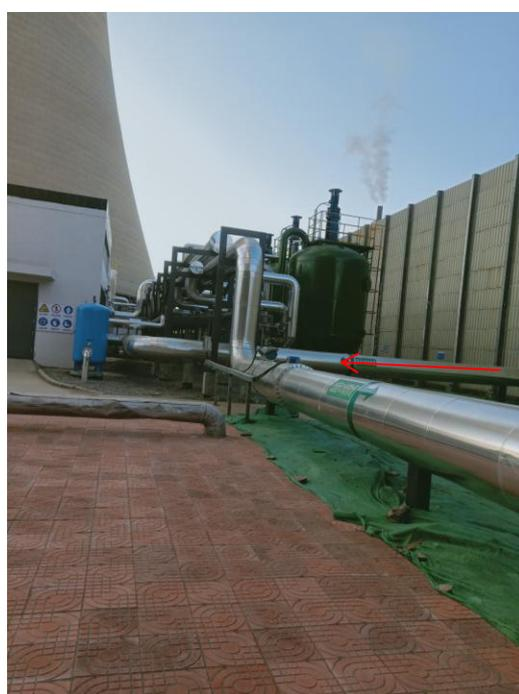
图 2-14 循环水旁滤母管
