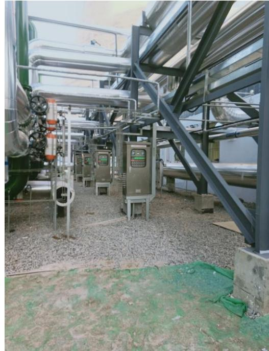
图 2-4 纤维球过滤器电磁阀箱
