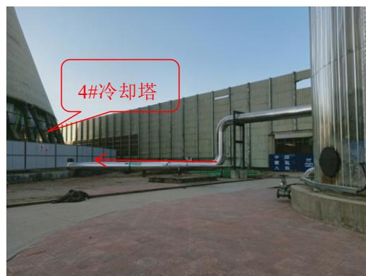
图 2-12 过滤器至 4#冷却塔输送水管
