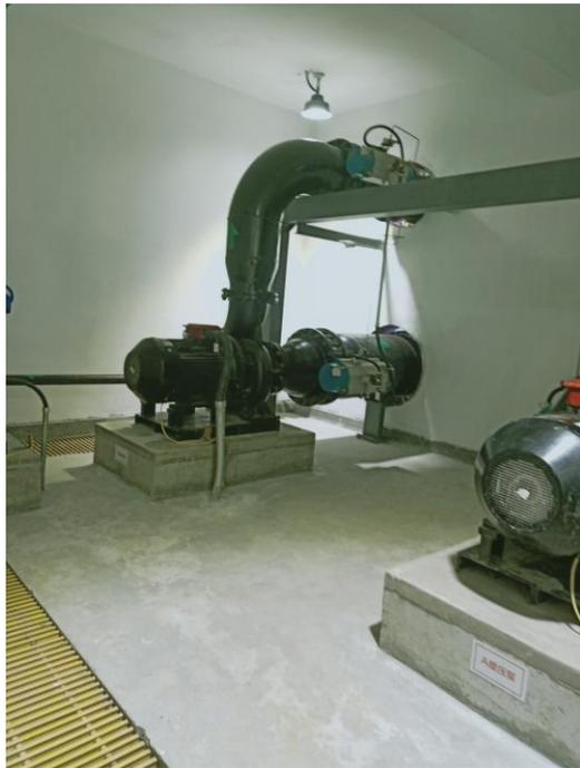
图 2-7 反洗废水输送泵
