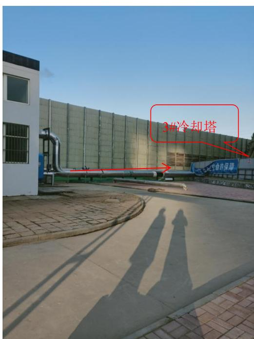
图 2-13 过滤器至 3#冷却塔输送水管
