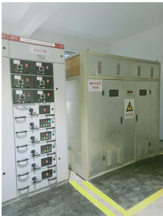
图 2-9 循环水旁滤装置变压器
