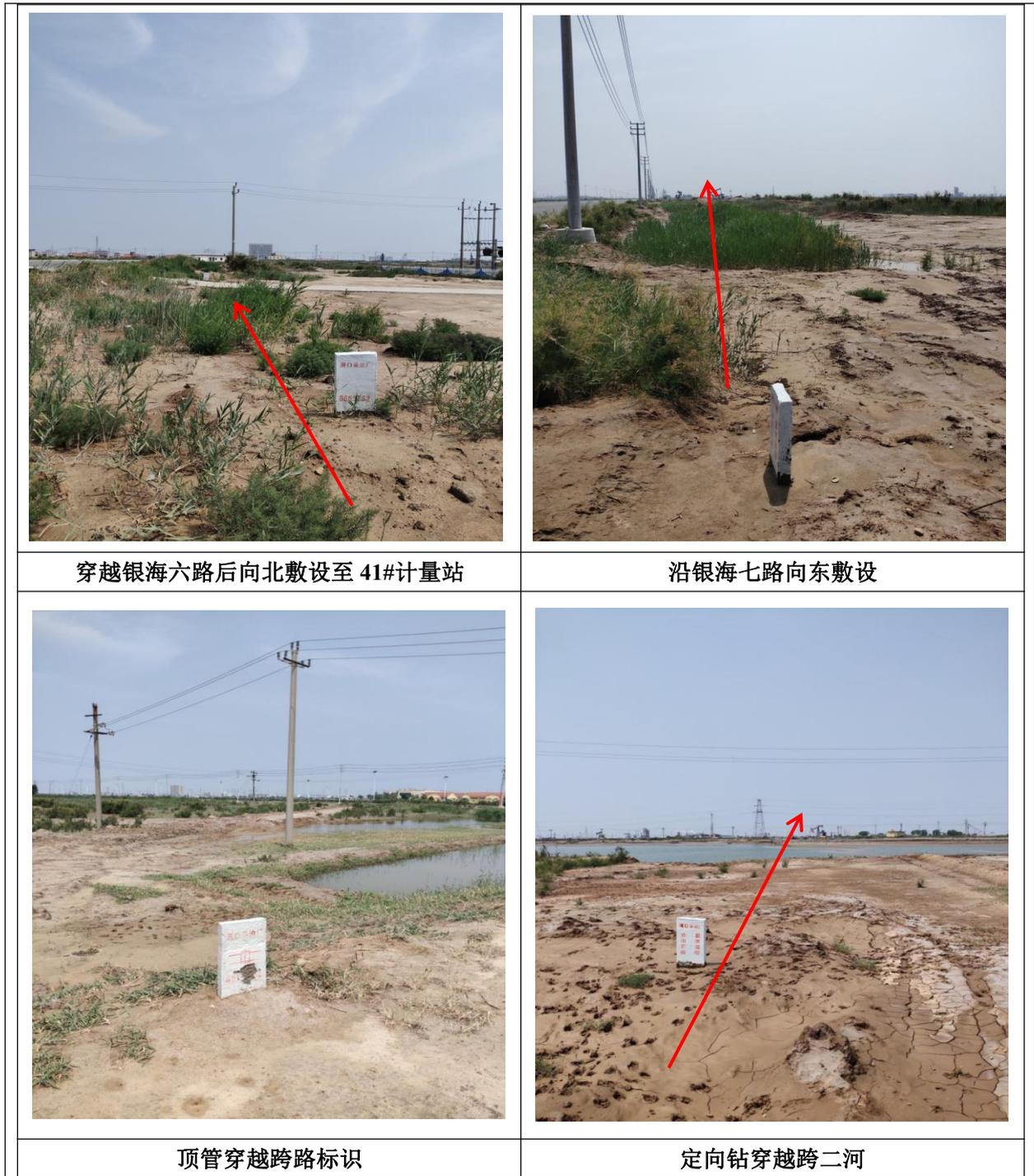
图 2-2 更新管线现场照片
