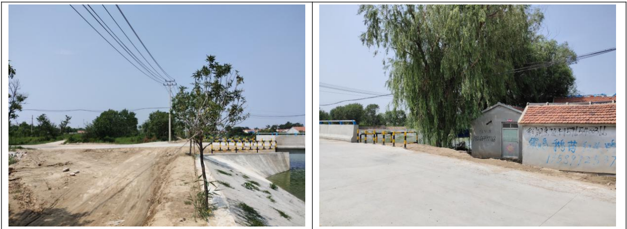
图 4-1 桥梁周边植被恢复情况图
