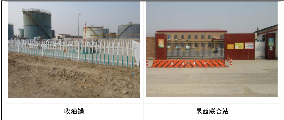
图 2-14 垦西联合站改造相关照片
