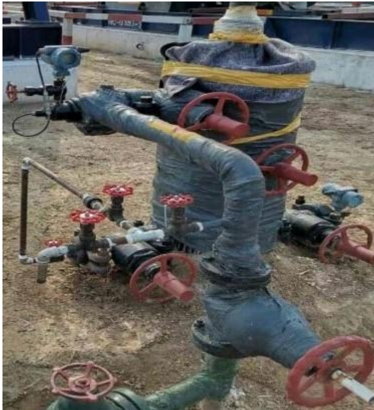
埕 11-平 8 套管气回收装置
