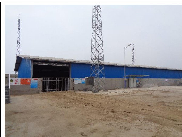
临盘采油厂油泥砂贮存场
