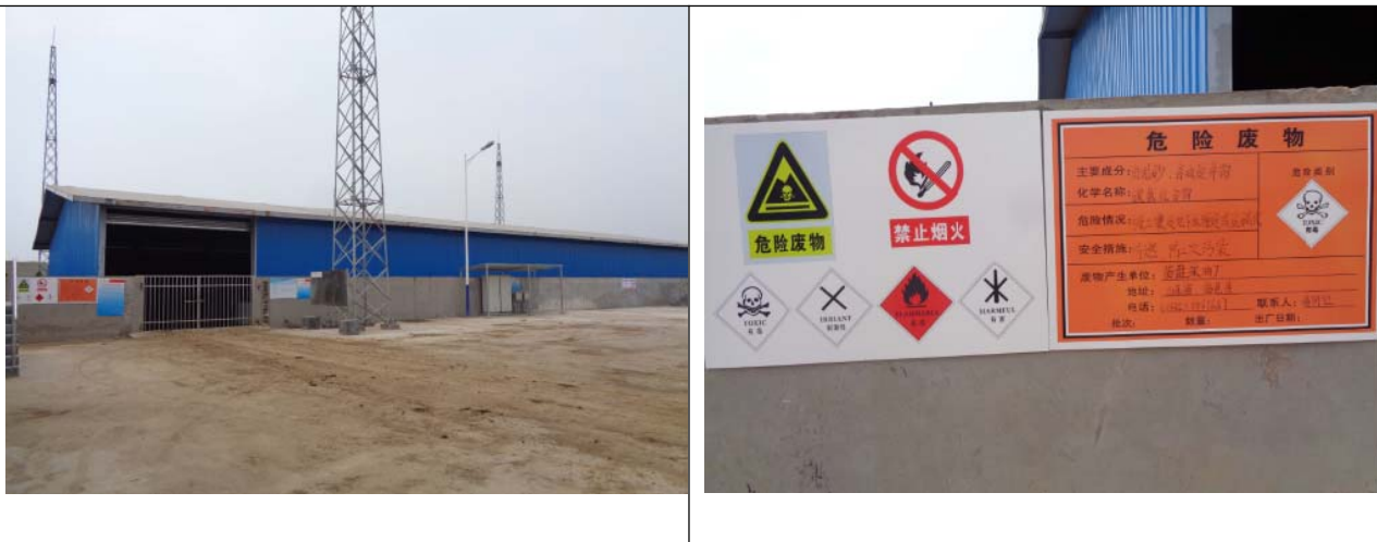
图 5-6 临盘采油厂油泥砂贮存场
