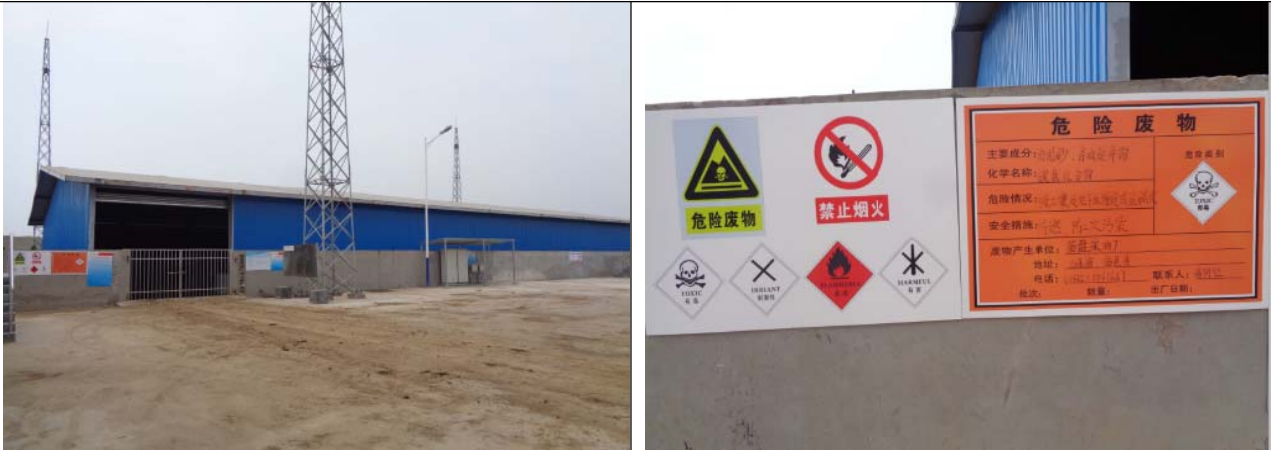
图 5-6 临盘采油厂油泥砂贮存场
