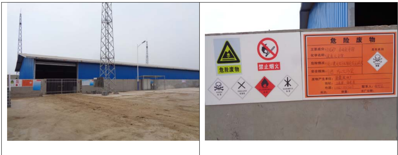
图 3-1 临盘采油厂油泥砂贮存场
