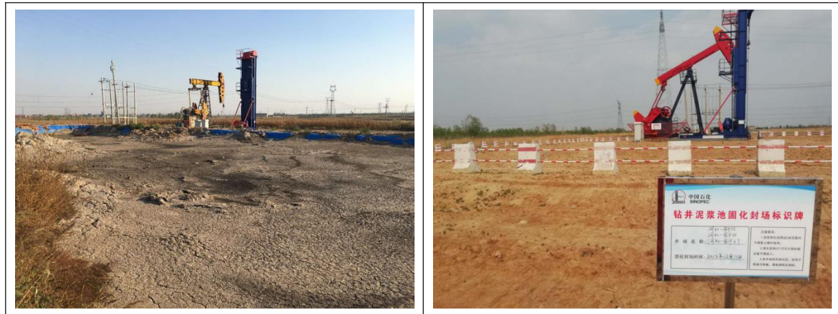
图 5-4 井场固化泥浆池前后对比照片
