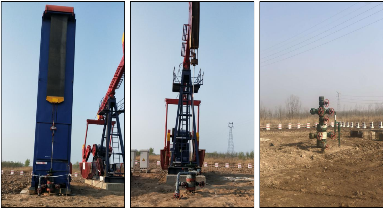
图 3-1 井场建设图（井号依次为河 82-斜 35、河 82-斜 36、河 82-斜 37）
