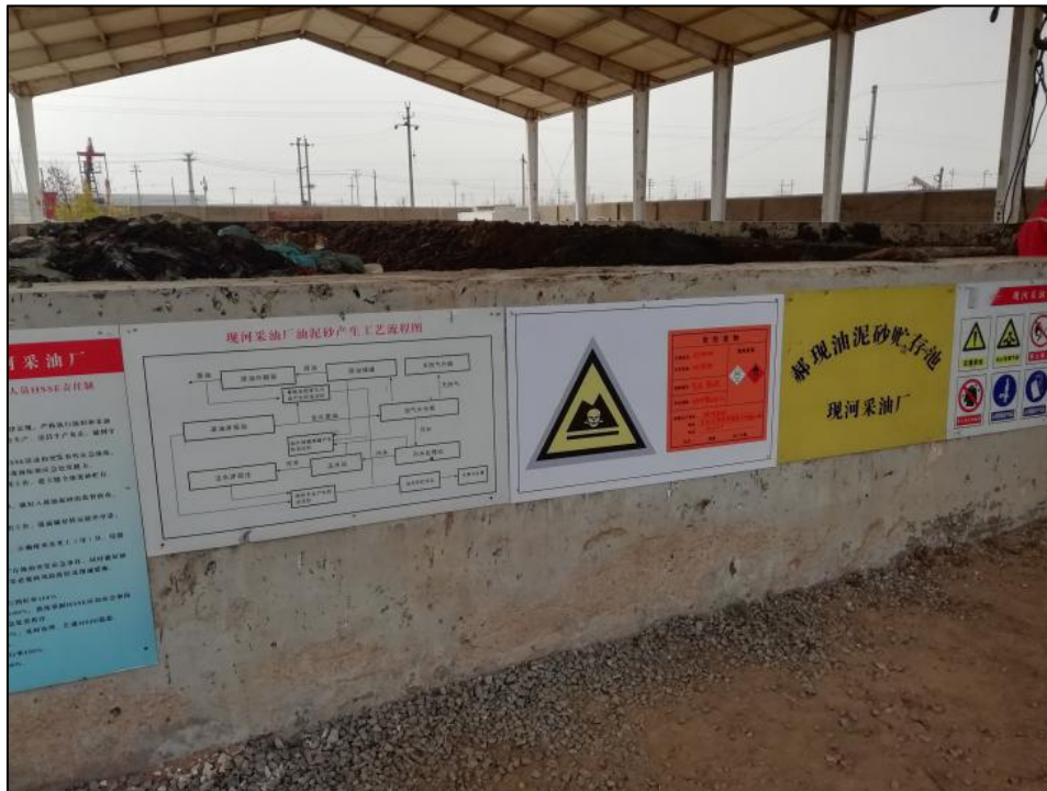
图 5-5 郝现油泥砂贮存场
