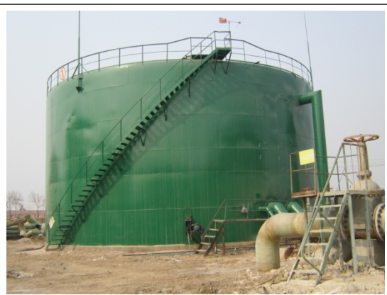
3000m 3 混凝沉降罐
