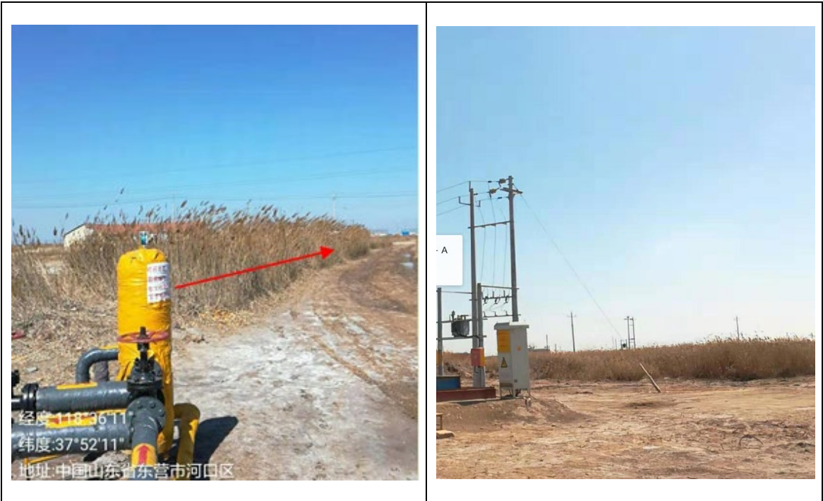
图 5-1 井场周边、管线临时占地生态恢复情况
