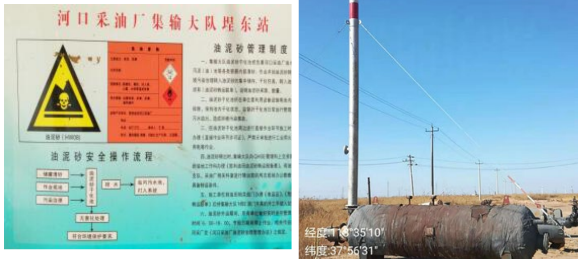
危废暂存场所标识牌
